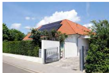
Foto: meinhubach Photographie
